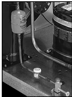
MONTAJE PREVIO DE TUBERÍAS ESTÁNDAR
